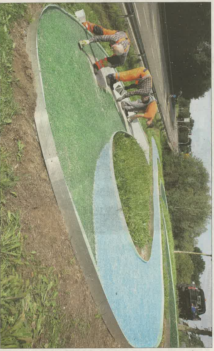
In den vergangenen Tagen hat der Bauhof das Logo der Remstal-Gartenschau am „Optionshügel“ an der B 29 farblich gestaltet. Hierzu wurde die Form betoniert und farbige Steine in das Logo geklebt.
